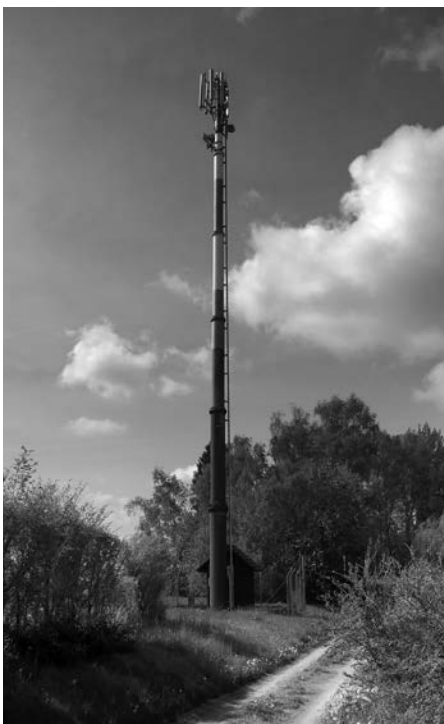
Obr. 1 – Hnízdiště kavky obecné ( Corvus monedula ) v telekomunikačním stožáru u Radostic (foto V. Mikeš 16. 5. 2017).
