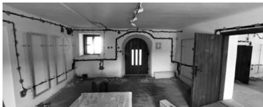
Práce na nové elektroinstalaci ve 3. expoziční místnosti v přízemí
