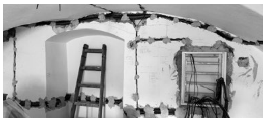
Nový rozvaděč a rozvody kabelů v 1. expoziční místnosti v přízemí
