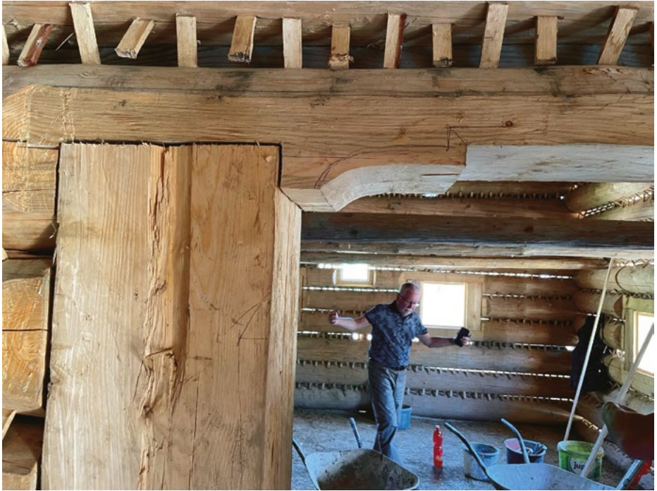
Detail nákresu okosení dřevěného sedlového portálu do jízby v usedlosti je dílem prof. Jiřího Škabradý. Foto Ivan Náprstek
