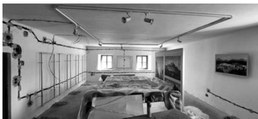
Práce na nové elektroinstalaci ve 2. expoziční místnosti v přízemí
