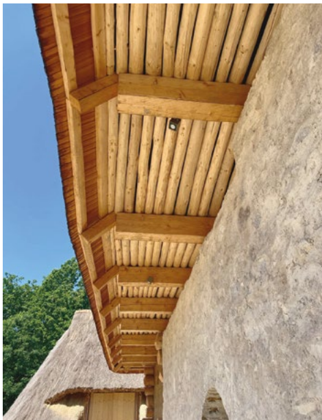
V roce 2022 došlo k doplnění krytí zápraží domu v areálu dvorce poválky. Foto Ivan Náprstek
