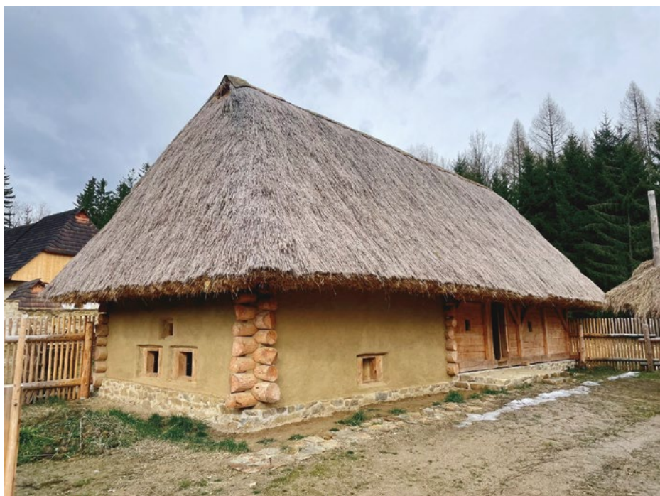
Stavebně dokončená chalupa v návsi včetně oplocení. Foto Ivan Náprstek
