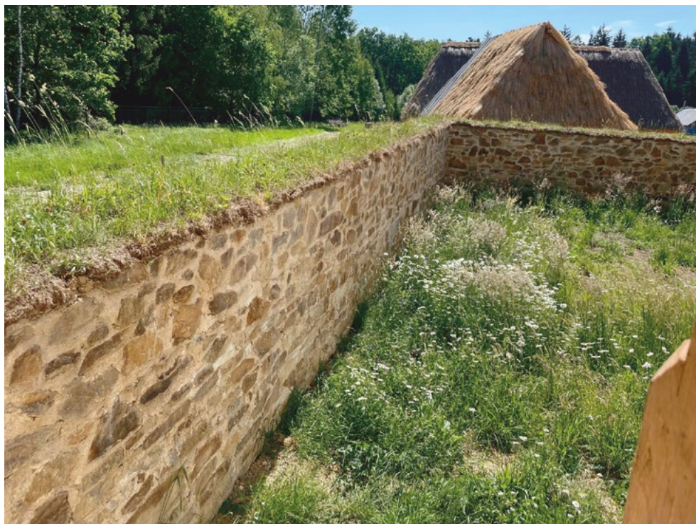
Ukázka krytí koruny ohradní zdi dvorce tzv. drnováním. Foto Ivan Náprstek
