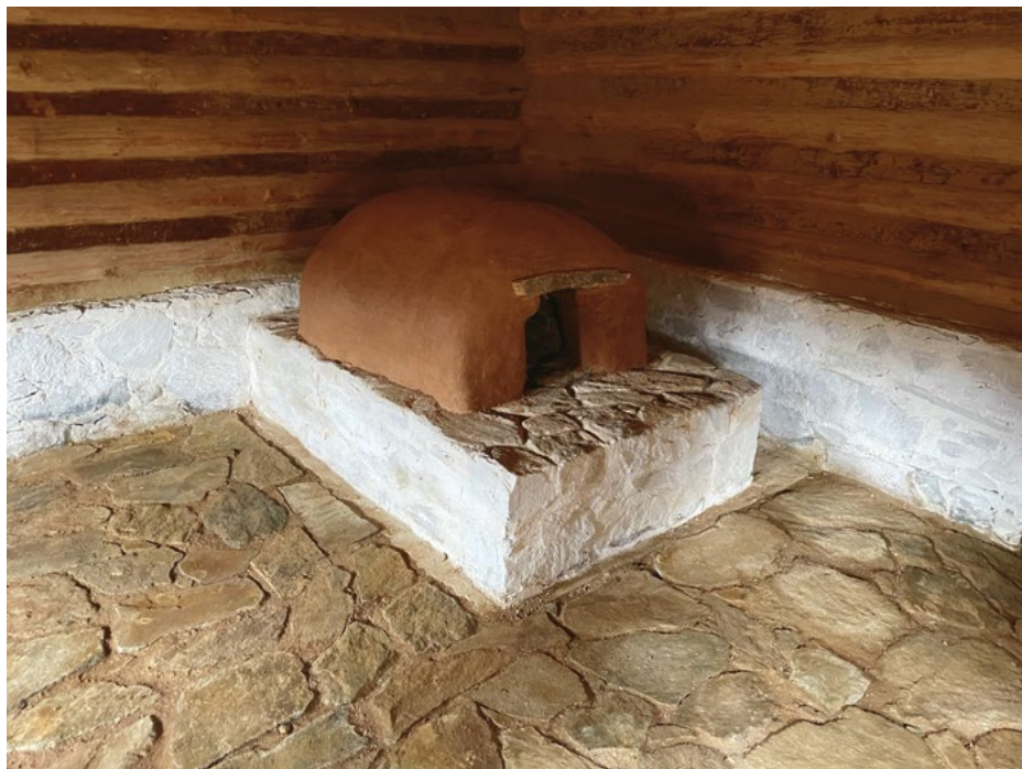
Interiér chalupy s dokončenou dýmnou pecí. Foto Ivan Náprstek
