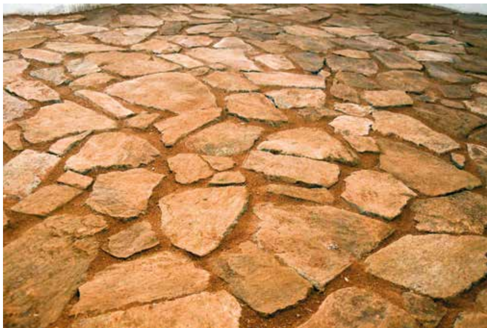
Kamenná dlažba v komoře domu ve dvorci. Foto Ivan Náprstek.
