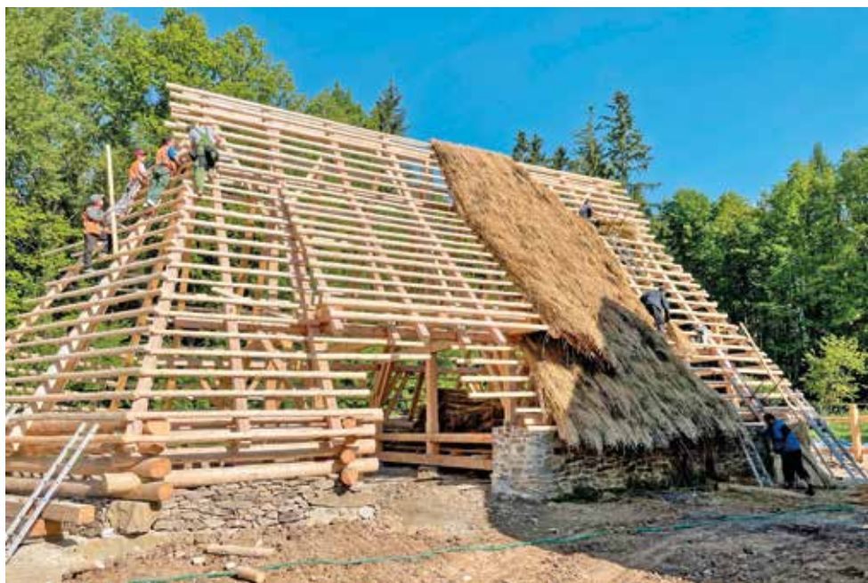
Pokládka doškové krytiny na stodolu ve dvorci. Foto Ivan Náprstek.
