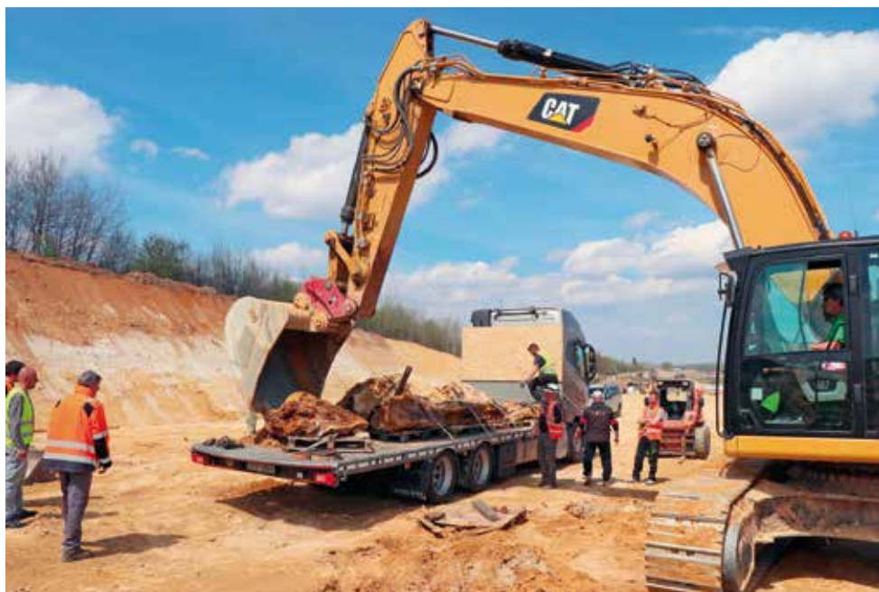
Pro nakládání velkých kusů bylo nezbytné použití těžké techniky.
