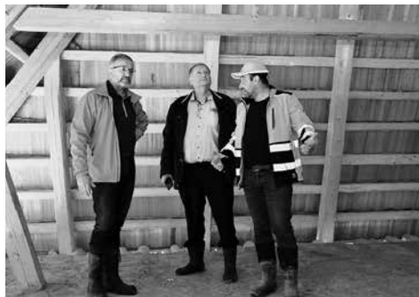
Vedoucí Odboru kultury a památkové péče Mgr. Patrik Červák, ředitel Jihočeského muzea Ing. František Štangl a stavbyvedoucí Petr Heřmánek v půdním prostoru domu ve dvorci v rámci předání I. etapy stavby Archeoskanzenu Trocnov 30. 8. 2021. Foto Marek Svoboda.
