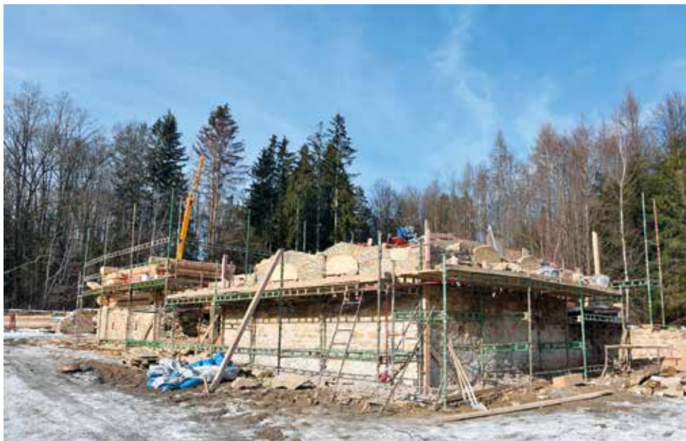
Vyzdívání kamenné obezdívky roubených stěn obytného domu ve dvorci.
