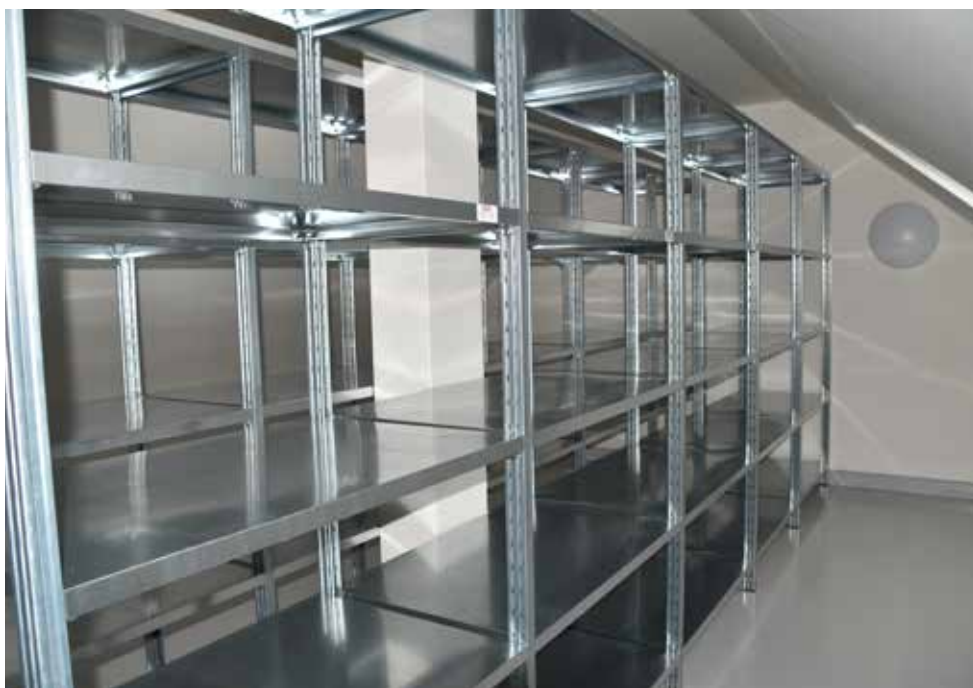
Detaily interiéru rekonstruovaného depozitárního objektu v Lednicích.
