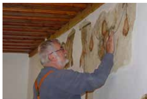
Restaurátor A. Hamsík při obnově fresek v Rytířském sálu.
