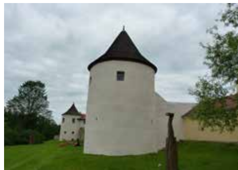
Bašta B po vyspravení fasády a nátěru.
