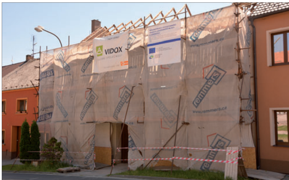
Budova depozitáře v Ledenicích v rekonstrukci.
