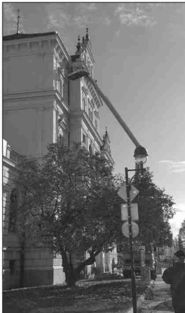
Oprava zábran proti holubům 8. 11. 2016.
