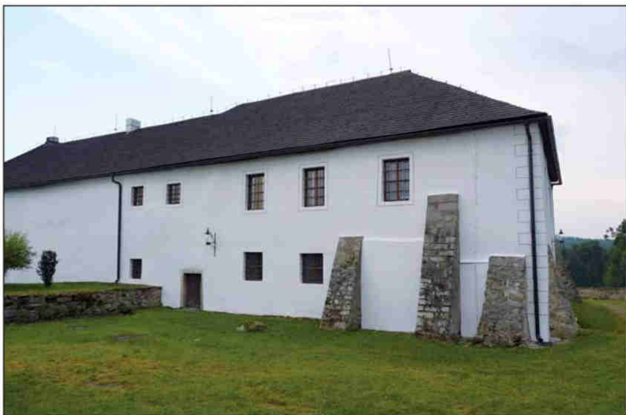
Severozápadní část tvrze po opravě fasády a jejím nátěru.
