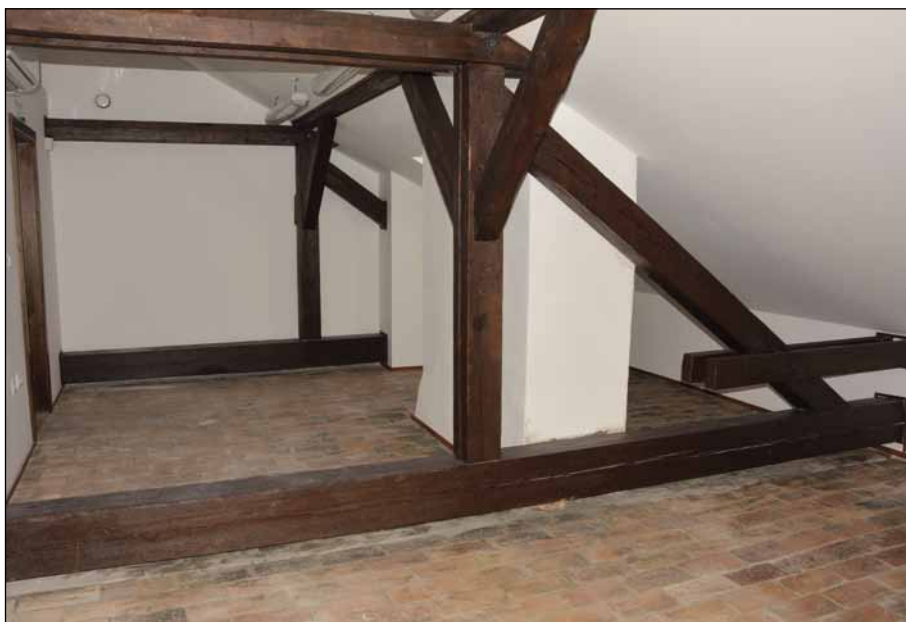
Ukázka prostorově atypických depozitárních místností.
