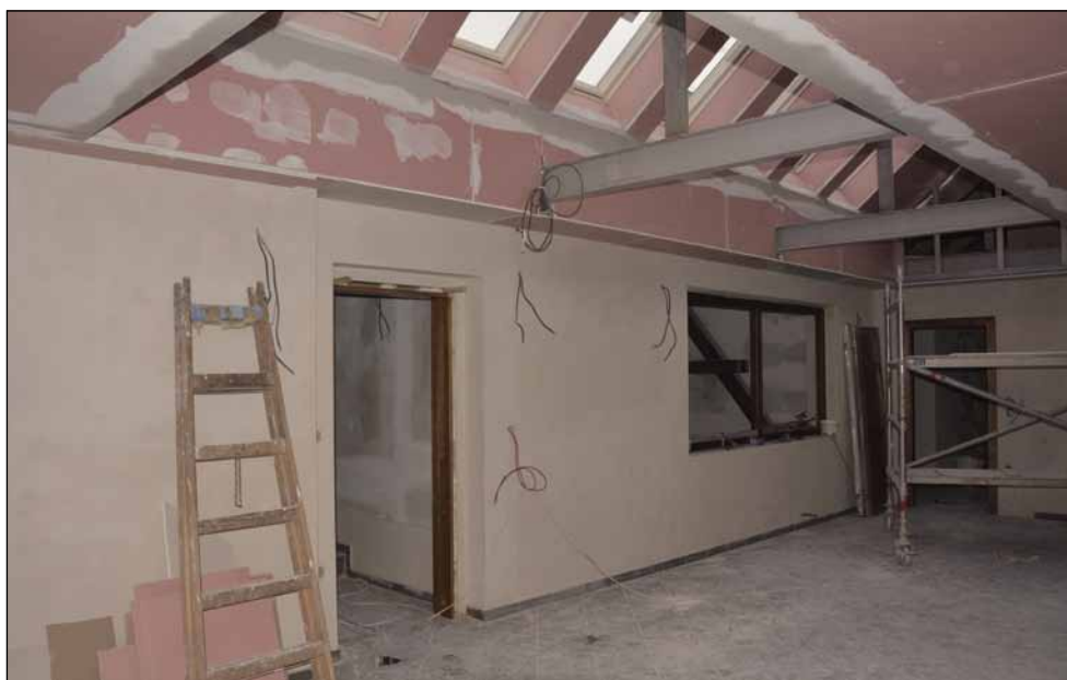
Zastřešená hala v podkrovních prostorách před dokončením.
