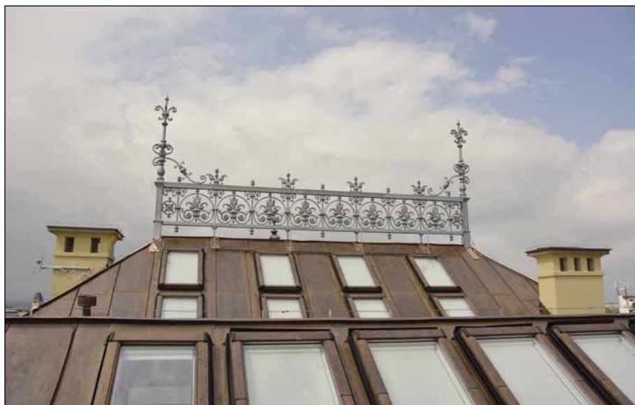
Nově opravená střecha s klempířskou výzdobou.
