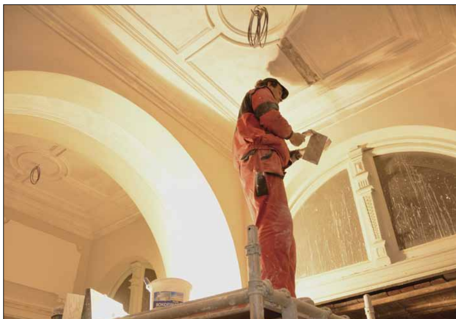
Opravy štukové výzdoby.
