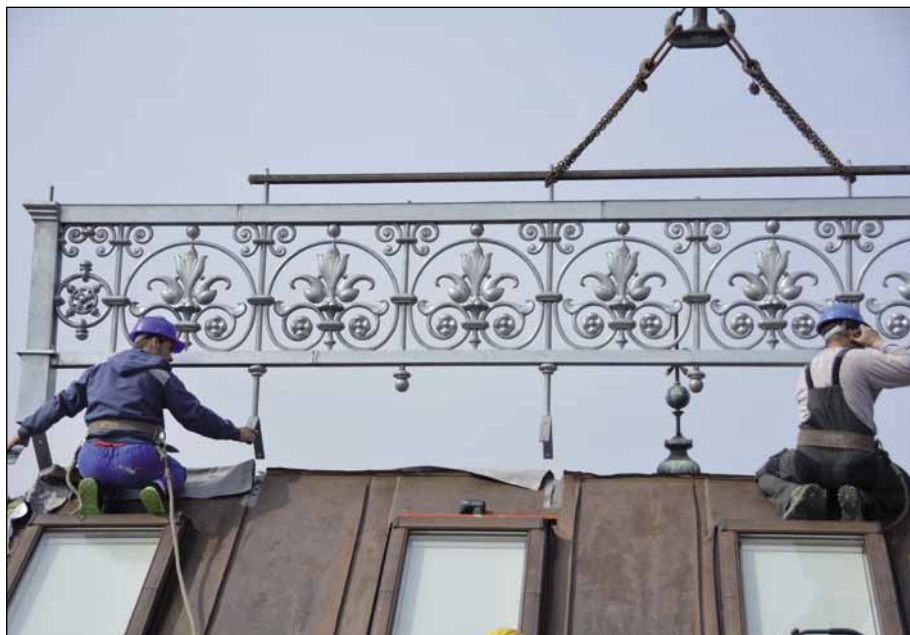
Usazování repliky klempířské výzdoby na střechu.
