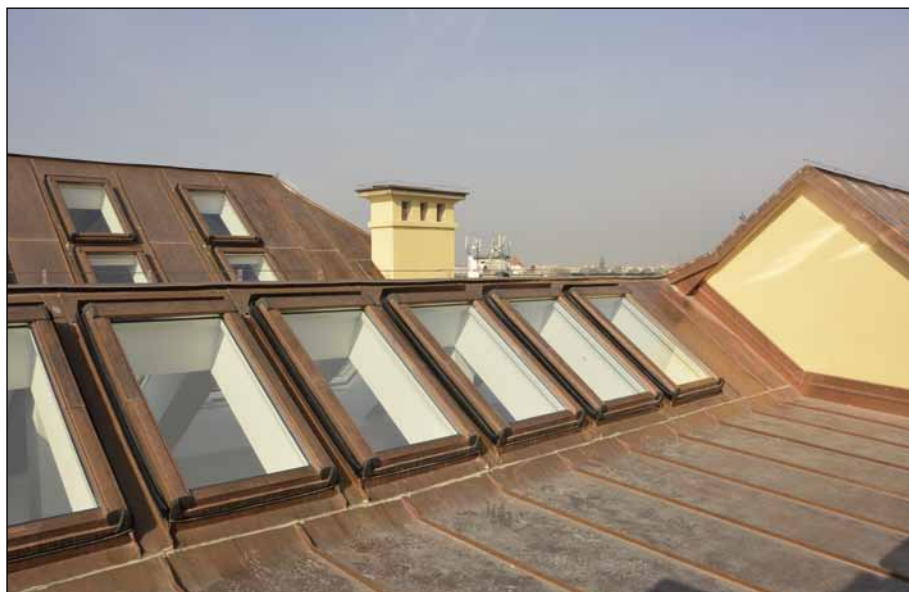
Sířešní okna nad halou v podkrovní.
