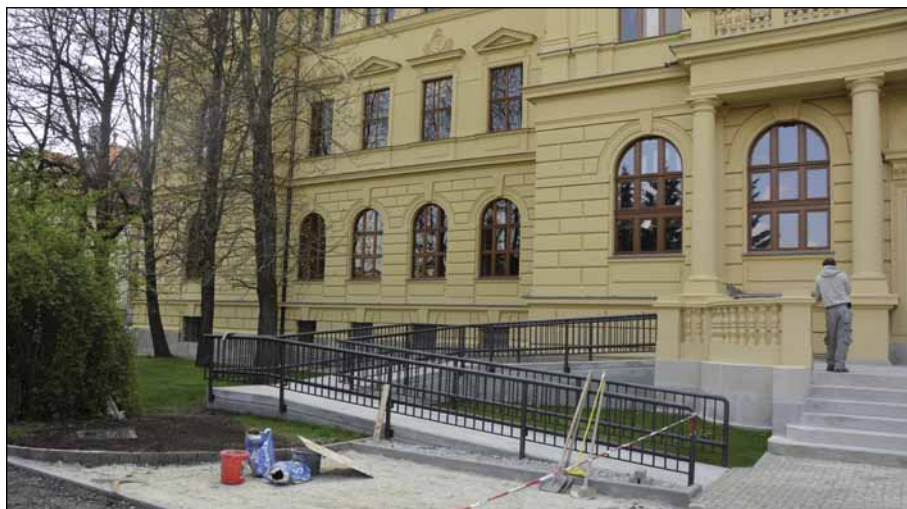
Vlevo nově vybudovaná nájezdní plošina pro osoby se zdravotním postižením.
