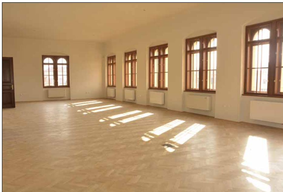
Rekonstruovaný výstavní sál se vzduchotechnickým zařízením.
