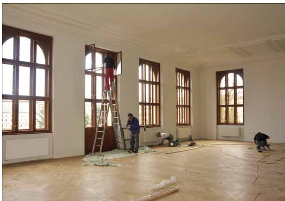
Úpravy oken a podlahy ve výstavním sále.
