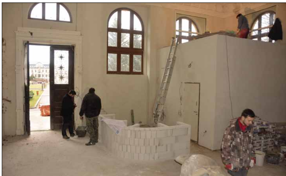
Budování recepčního pultu.
