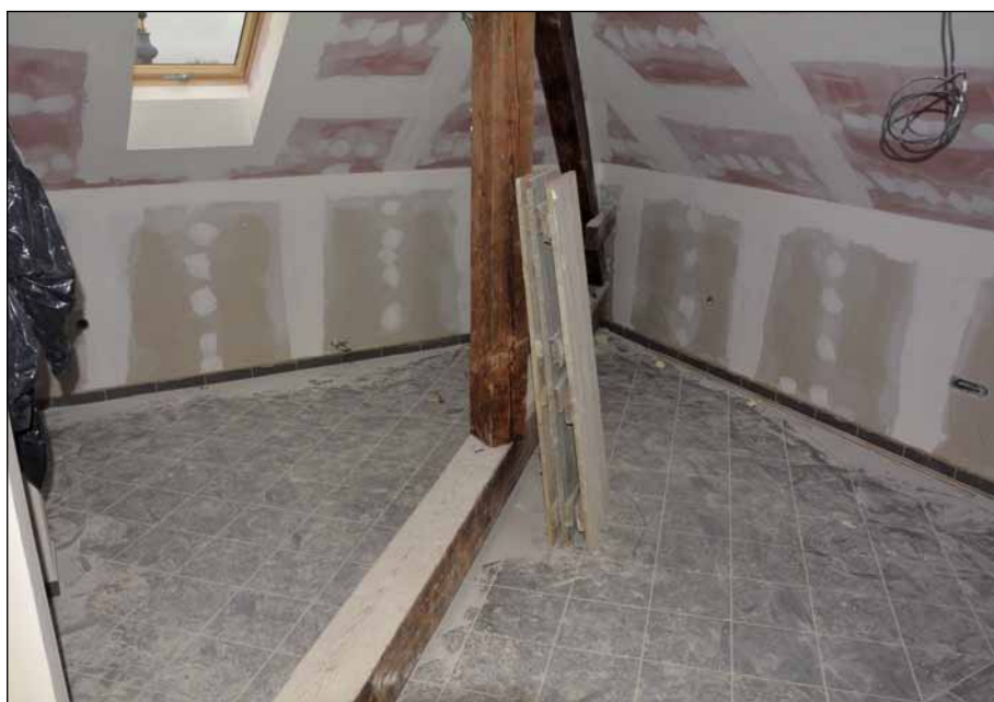
Nově vybudované prostory na bývalé půdě.
