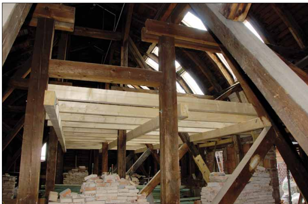
Dřevěná konstrukce půdní vestavby budoucích kanceláří ve střešní kupoli. (31. 7. 2013)
