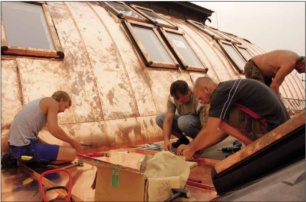
Klempířské práce na střeše atria se světlíky a kupole s okny budoucích kancelářů půdní vestavby. (19. 8. 2013)
