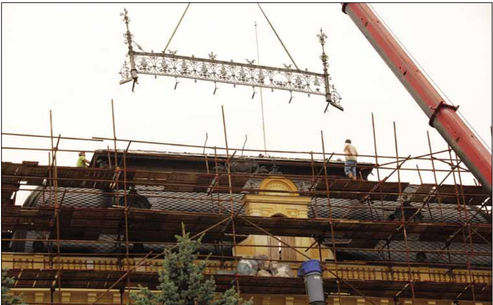
Demontáž zkorodovaného ozdobného zábradlí kupole, které muselo být nahrazeno novými kopiemi. (19. 8. 2013)
