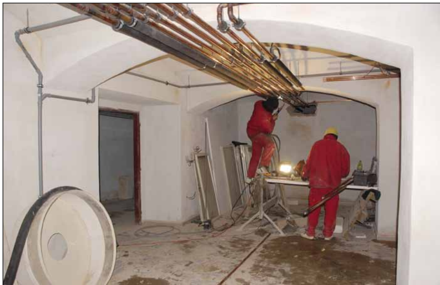
Součástí rekonstrukce byly nové rozvody tepla, vody a odpadů suterénem budovy. (5. 4. 2013)
