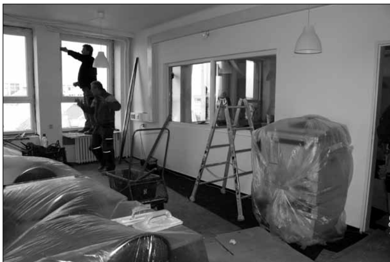
V dočasném sídle knihovny muzea ve Štávounionu proběhla řada technických úprav, z nichž provozně nejnáročnější byla výměna oken ve všech depozitářích, kancelářích a studovně v únorových dnech roku 2013.
