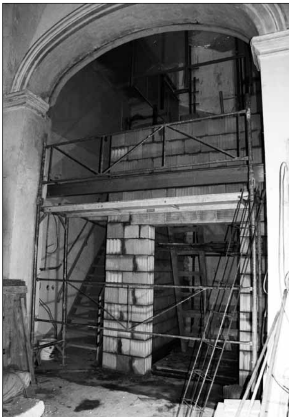
Začátkem roku byly zahájeny práce na vyzdívání druhé výtahové šachty nového osobního výtahu. (4. 2. 2013)
