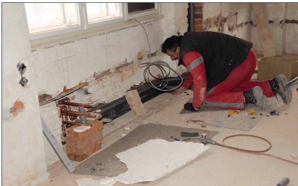
Rozvody topení ve výstavních sálech si vyžádaly zásah do omítek i zdiva místností. (8. 2. 2013)
