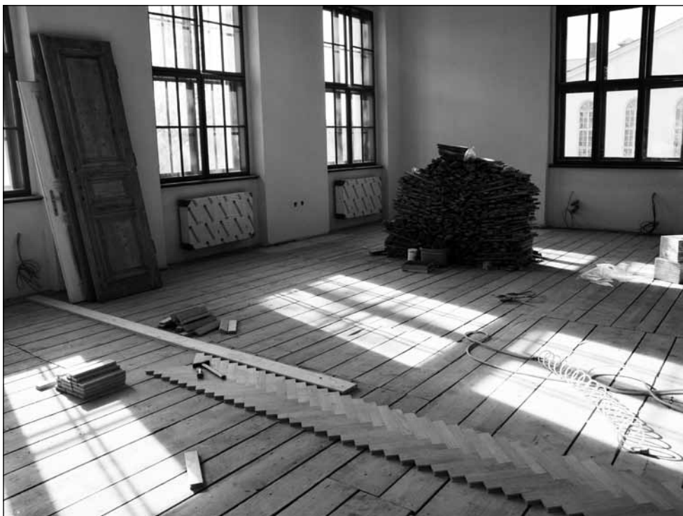
Součástí rekonstrukce budovy byla i rekonstrukce parketových podlah všech výstavních sálů a kanceláří. (4. 11. 2013)
