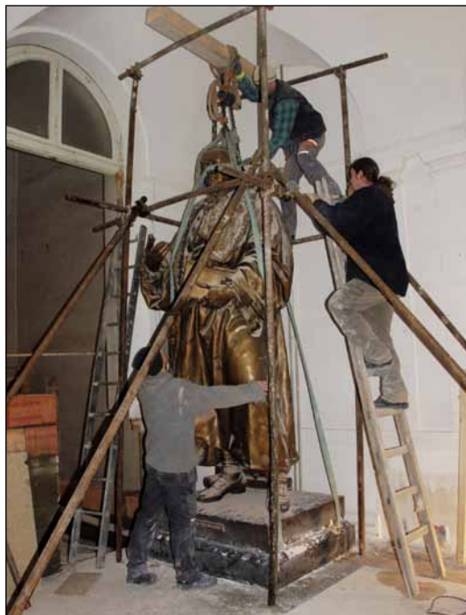
Sochy pánů van Sweetena a hraběte Kounice, zdobící 2. NP, musely být přemístěny (posunuty) o cca 1,5 metru, neboť „překážely“ vstupu do nového osobního výtahu. Průběh prací průběžně kontroloval také ředitel muzea, Mgr. Pavel Šafr, na fotografii vpravo. (21. 2. 2013)
