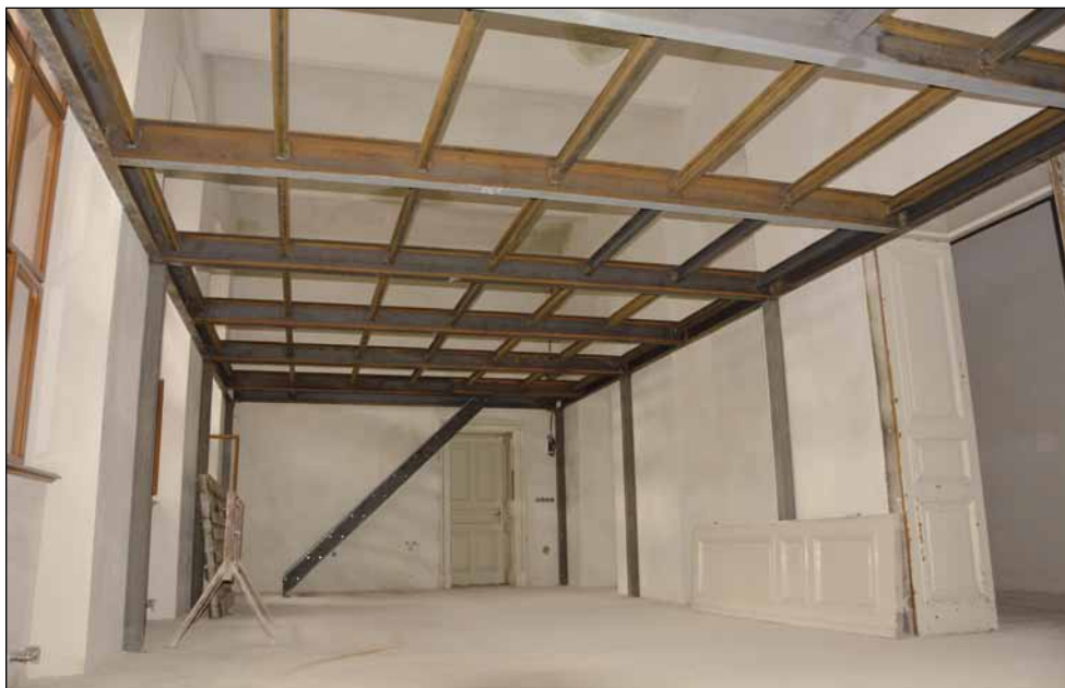
Montáž ocelové konstrukce mezistropu depozitáře knihovny v 1. NP. (7. 11. 2013)
