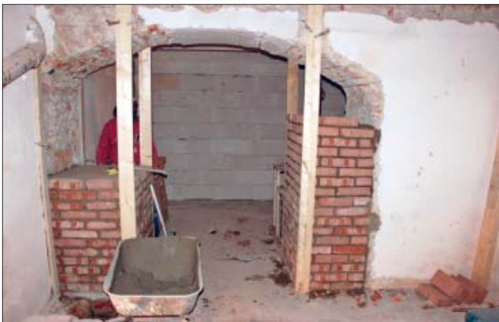
Z rekonstrukce ve sklepních prostorách.
