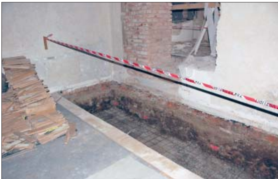
Z rekonstrukce podlahy výstavního sálu 119 v přízemí.
