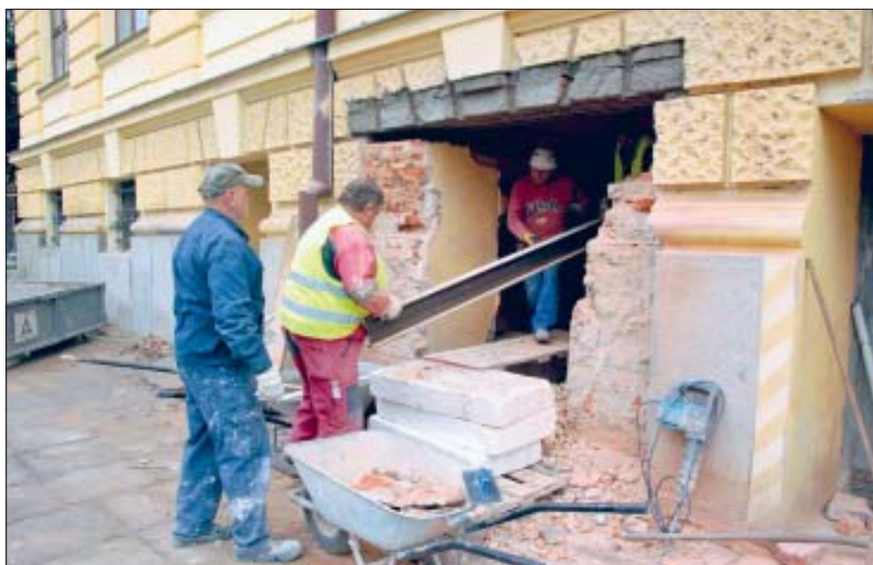
Stavební úpravy u bočního vchodu s garážemi.
