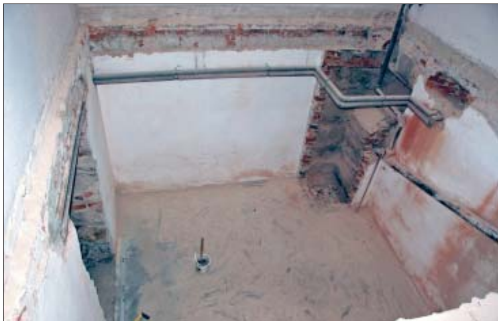
Pohled do výtahové šachty.
