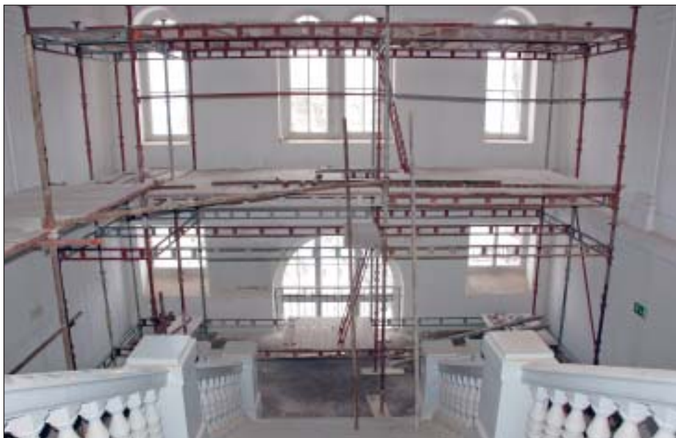
Z rekonstrukce schodiště.
