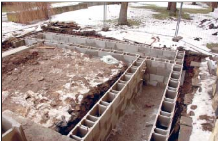
V roce 2012 se začal budovat speciální nájezd pro vozíčkáře, který doposud muzeum postrádalo.
